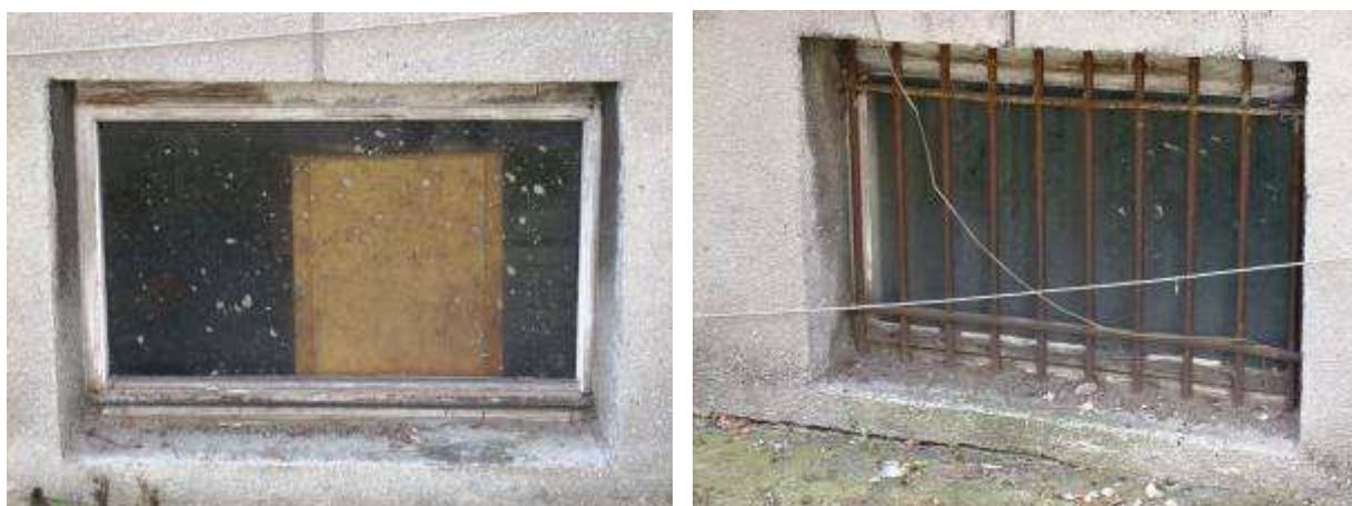
Rysunek 7 Okna pomieszczeń piwnic.
