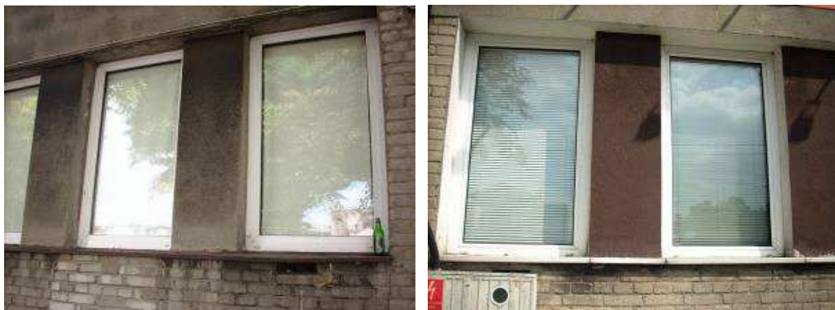
Rysunek 6 okna nowe w budynku dwukondygnacyjnym
