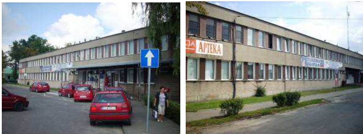
Rysunek 1 widok elewacji frontowej południowej - wejście główne do budynku)
